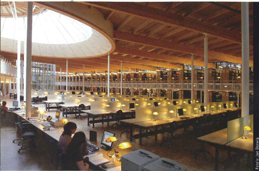
[De bibliotheek wordt overkapt door dakliggers van gelamineerd grenen en dakpanelen van geperforeerd spaanplaat.]
