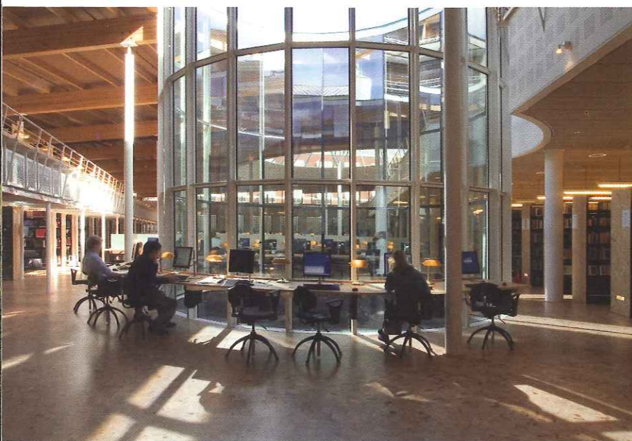
[Op de vloer van de bibliotheek is een laag van 2 cm kops gezaagd en gelakt grenen aangebracht.]
