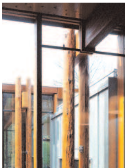
De samengestelde liggers overspannen zestien meter.
