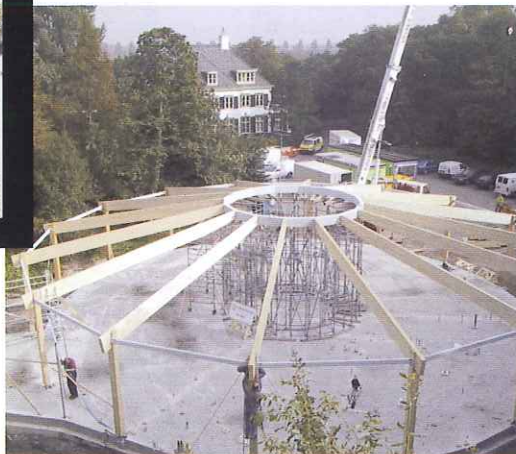
[Spatkrachten worden opgenomen door een stalen ring.]
