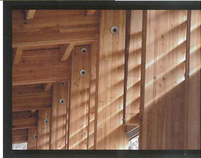
[Interieur met moment-overbrengende verbindingen (Orvelte).]
