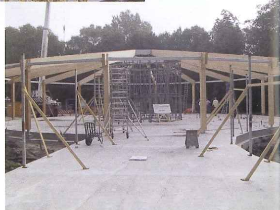
[Montage van de spanten voor het bedrijfsrestaurant in Noordwijk.]
