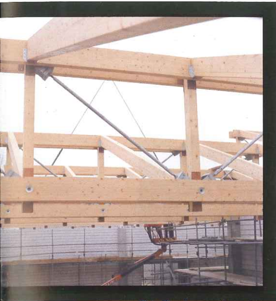
[Geplaatste spanten in Soest.]
